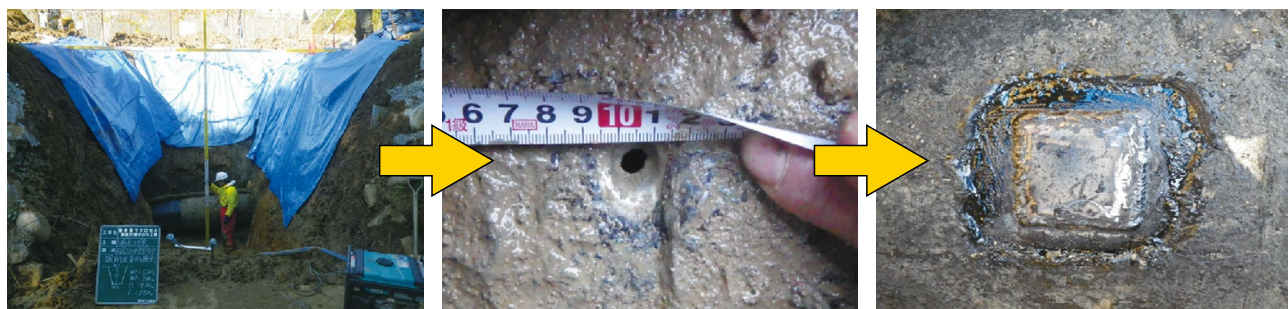
（φ700鋼管 腐食ピンホールによる溶接・掘削修理）
