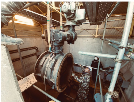
（笛吹市境川町藤埜地内 左岸 7-1 分木工 電動制水弁更新（Φ800mm）
