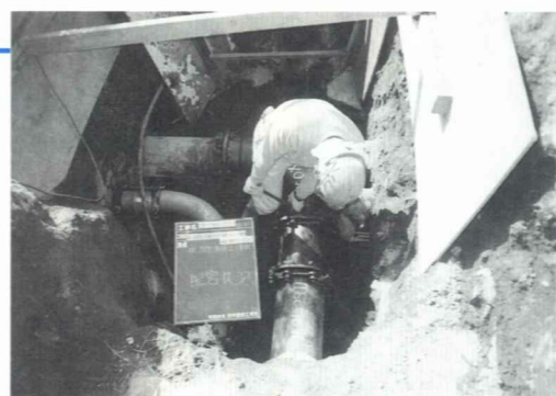
▲基幹改築工事
