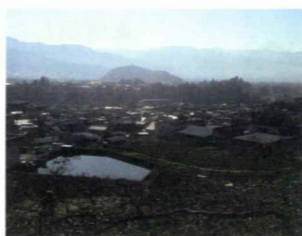
▲ 1-1号 ファームポンド
