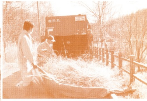
刈り草を琴川ダム残土処分場に運び入れて、緑化を推進(藁撒き工法)
